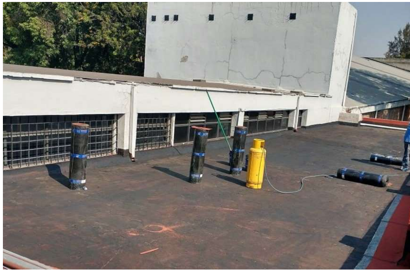
Trabajo de impermeabilización del Edificio E
